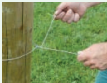
2. Loses Drahtende 3-mal um den Zugdraht wickeln
