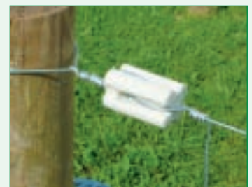
8. Drahtende lang lassen zur Querverbindung
