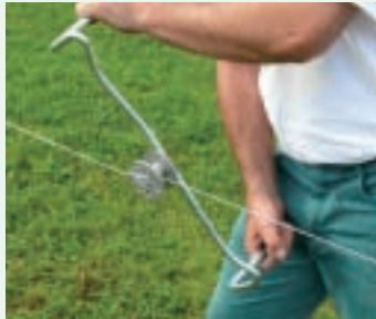
Spannbügel solange drehen bis die richtige Zaunspannung erreicht ist.
