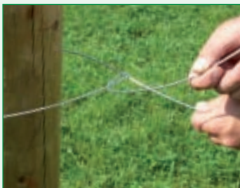
1. Draht um den Pfahl legen und eine Schlaufe bilden
