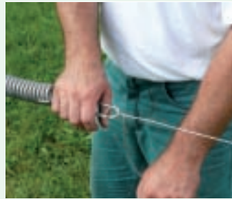
Die überstehenden Drahtenden um den Zaundraht wickeln
