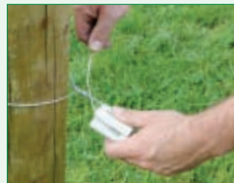
3. Loses Drahtende durch den Zugisolator hindurchführen
