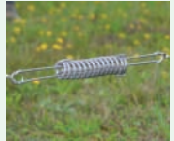
Die Befestigung auf der anderen Seite wiederholen und Feder mit dem rotierenden Spanner vorspannen.
