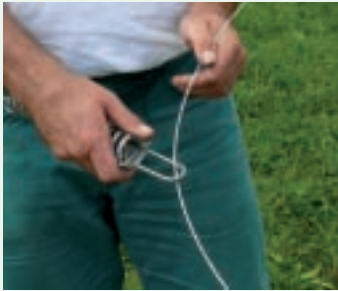
Draht in einen Bügel der Feder einführen
