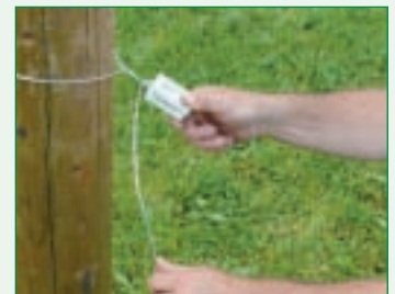
4. Ende 5-mal um den Zugdraht wickeln
