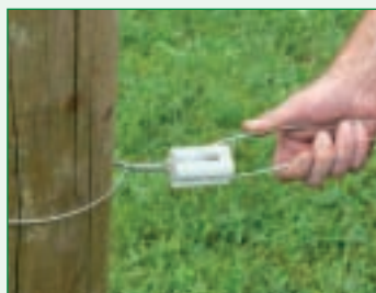
6. Zaundraht durch den Zugisolator hindurchziehen
